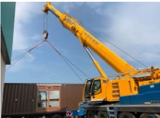
Figure 1: Installation d'une cabine 500 kW pour local LBAF
